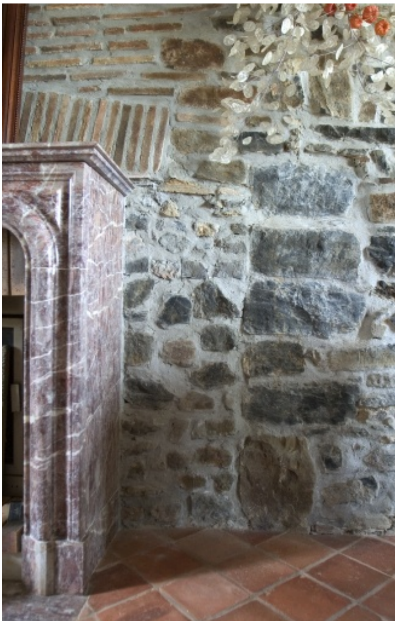
Partie est du bâtiment principal, salle du rez-de-chaussée : détail de la cheminée actuelle et vestiges de l'ancienne cheminée.
