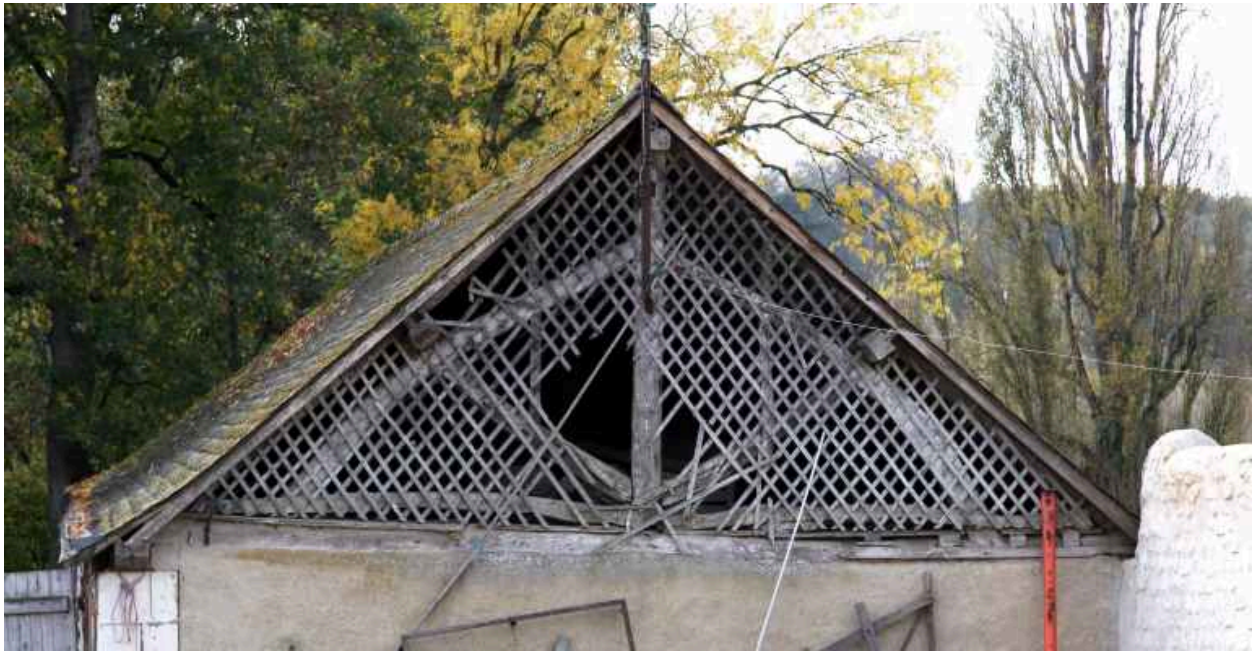
La ferme du château : charpente de l'étable.
