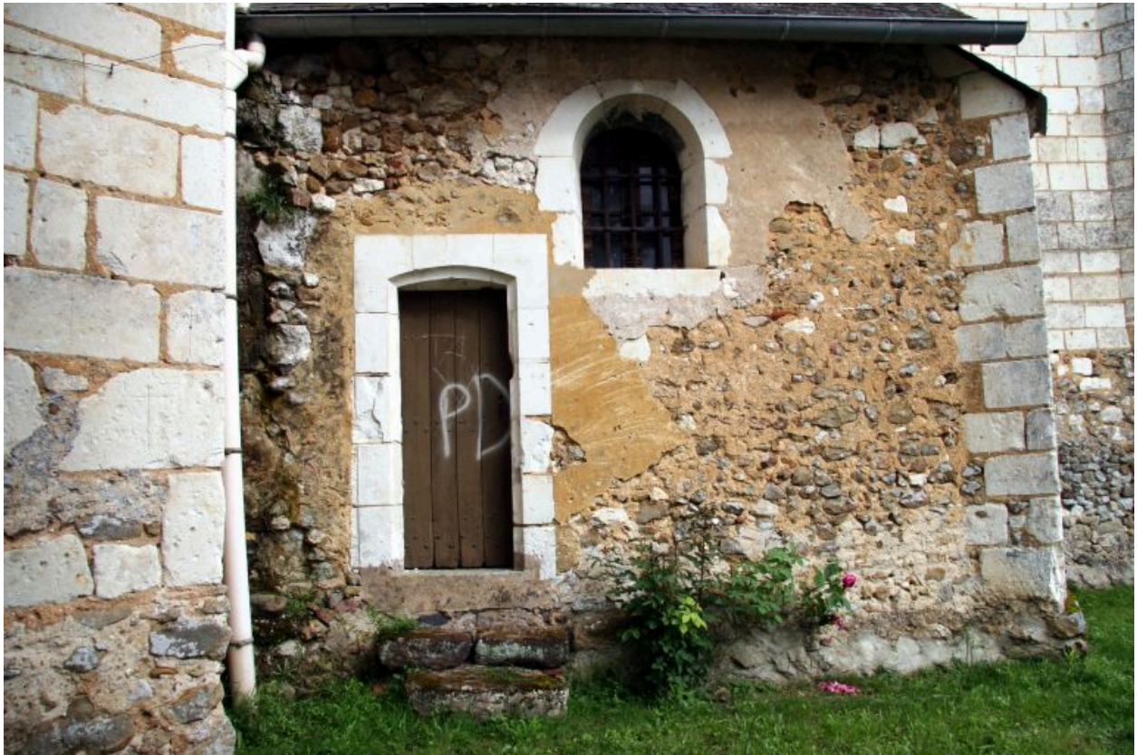
Façade de l'oratoire.
