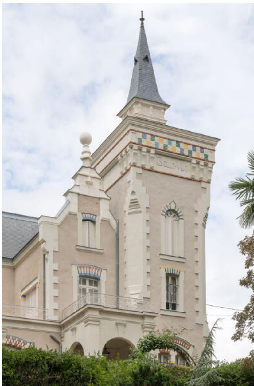
Façade sud. Détail de la tour d'escalier.
