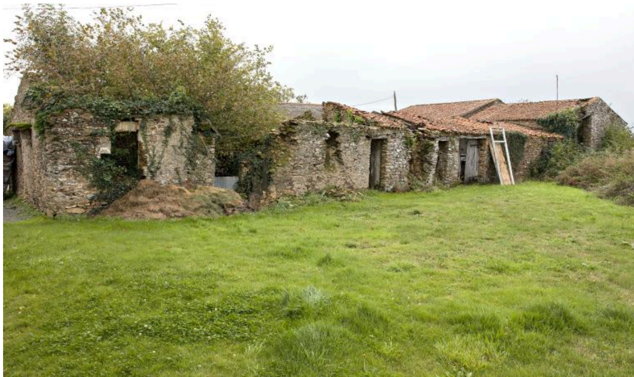
Vestiges d'habitations aujourd'hui ruinées. La Rinière des Landes, Le Loroux-Bottereau.
