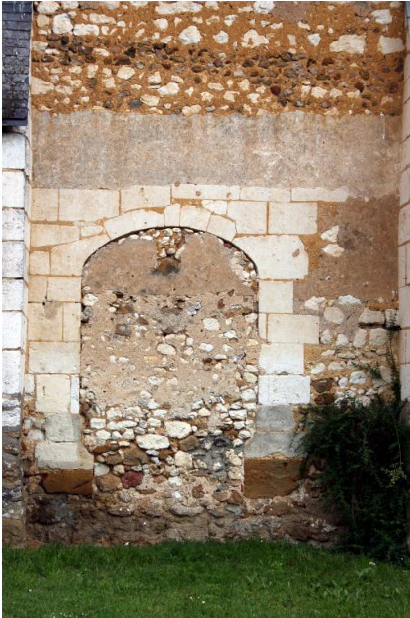
Mur sud de la nef, première travée : baie en anse-de-panier.
