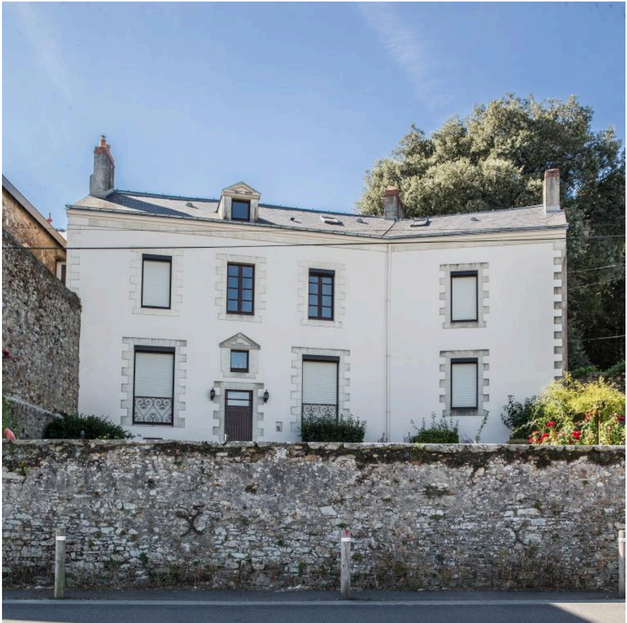
Maison, 5 rue du Verger.
