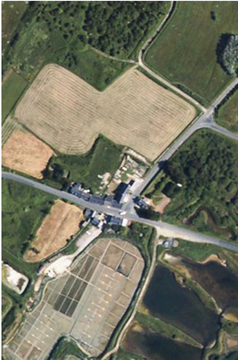
Vue aérienne de l'écart des Maisons-Brulées.
