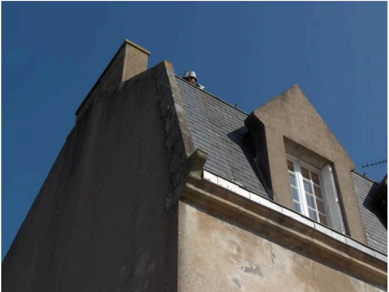
Détail de la toiture à pans brisés sur la façade sud.
