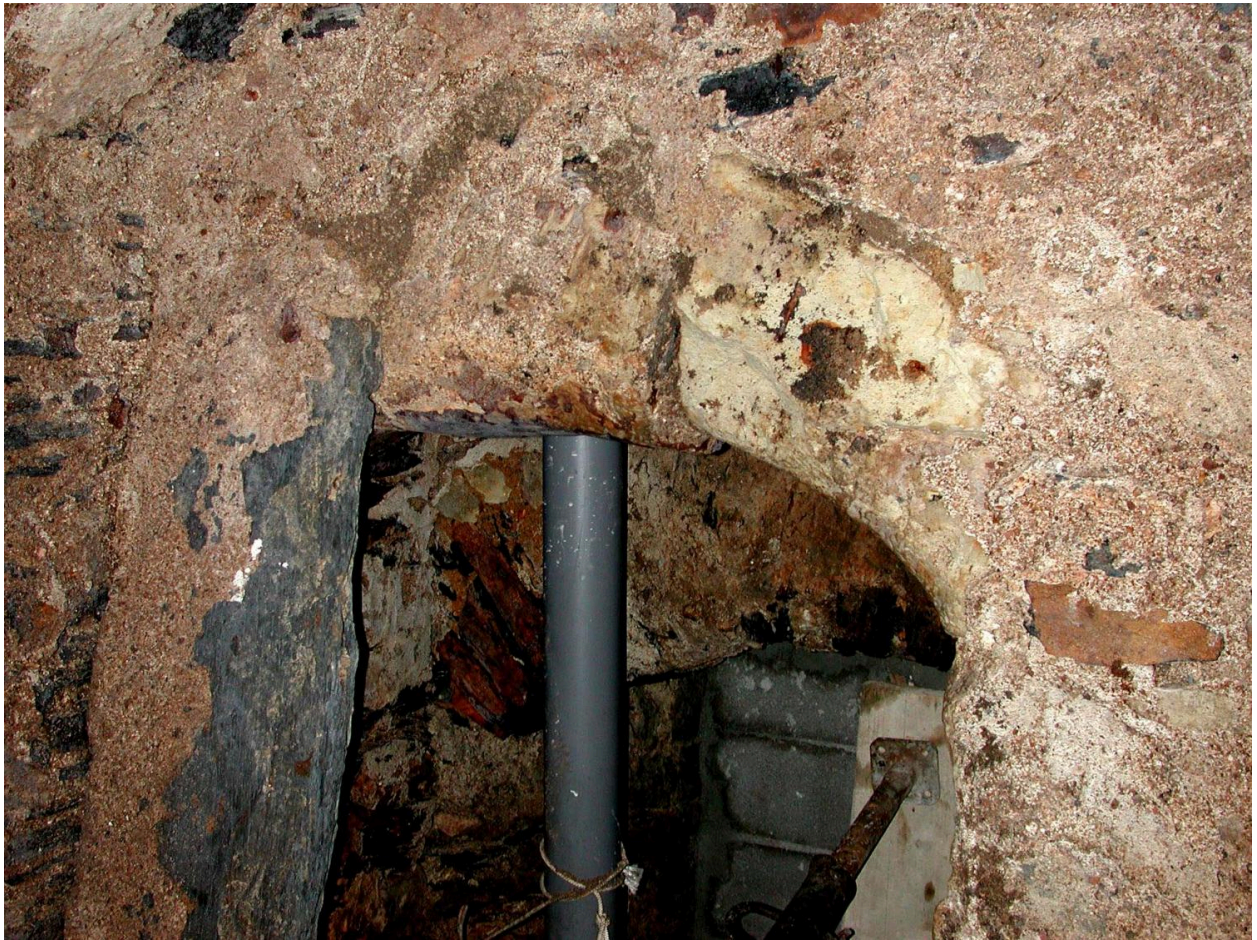
Sous-sol, angle postérieur gauche (sud-est) : porte condamnée, détail sur la plate-bande.
