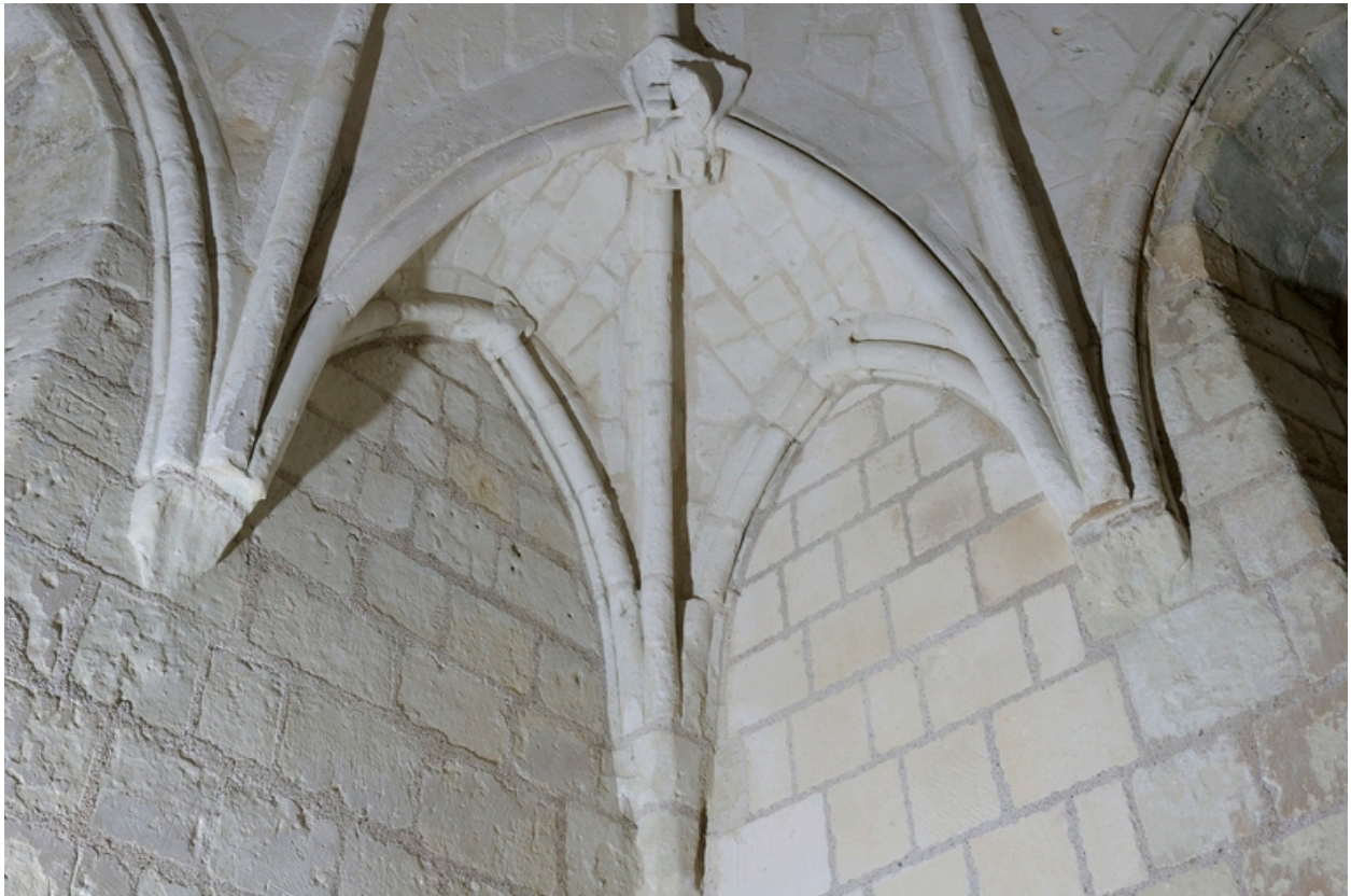
Chapelle haute, voûte, angle sud-ouest : détail de la trompe (dont clefs à ornements végétaux des formerets).
