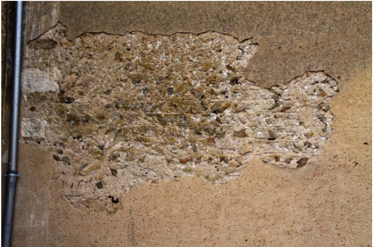
Nef, façade nord, détail : opus en épis.
