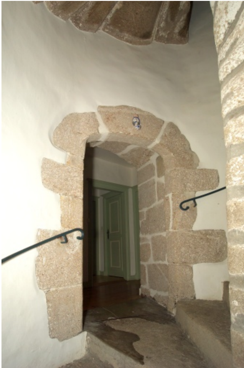
Volée d'escalier et porte pour l'accès au premier étage.
