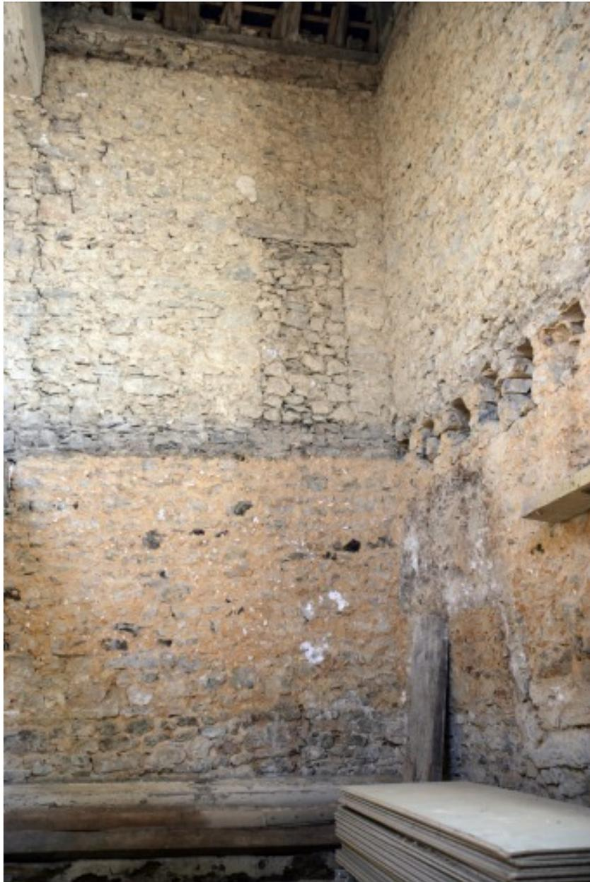
Intérieur du corps sud, pendant les travaux : l'angle sud-est des deux premiers niveaux avec la porte bouchée de l'étage.
