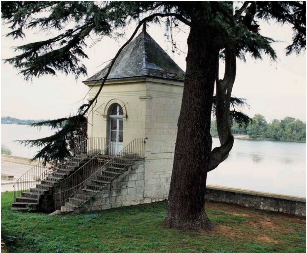
Pavillon : vue d'ensemble avant restauration.
