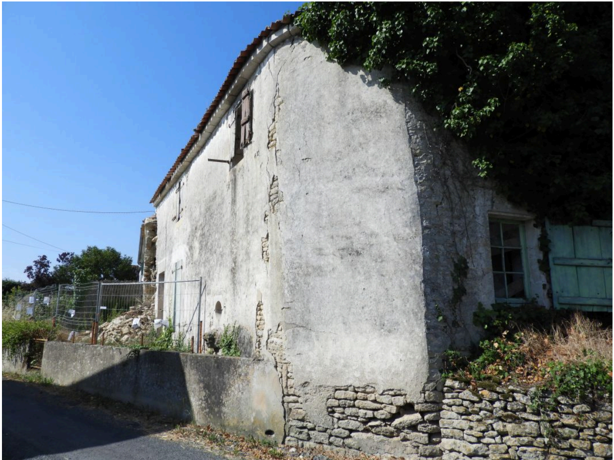
Le logis et son angle tronqué vu depuis le nord.
