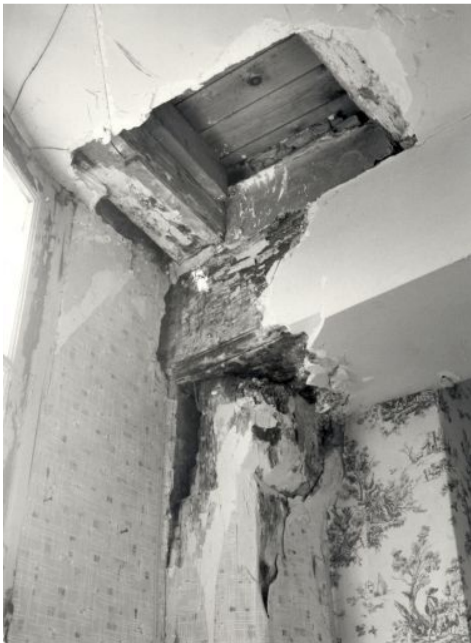
2e étage, pièce postérieure, mur droit : détails du poteau de soutien et d'une poutre moulurée du plafond.
