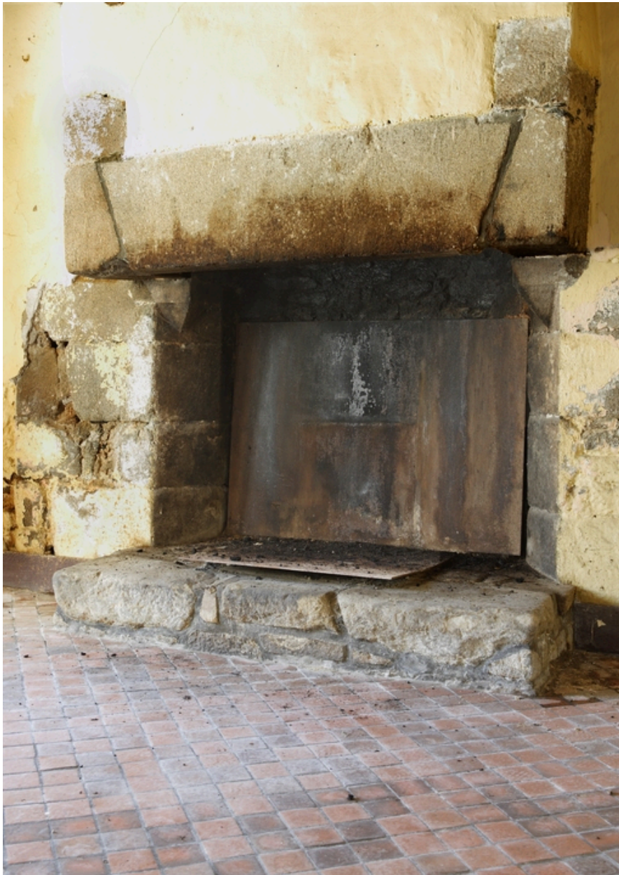
Aile ouest. Salle basse. Vue de la cheminée.
