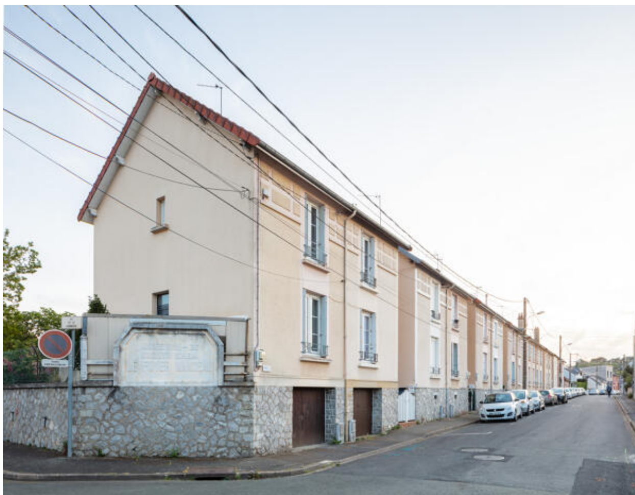
Vue des maisons du foyer manceau rue du Port Boyer.
