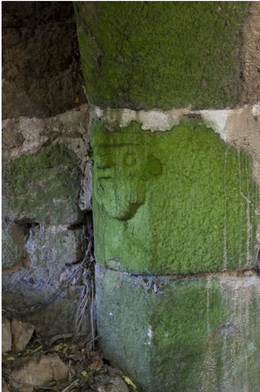
Cheminée sud de l'alignement sud, en ruines, détail du piédroit droit.
