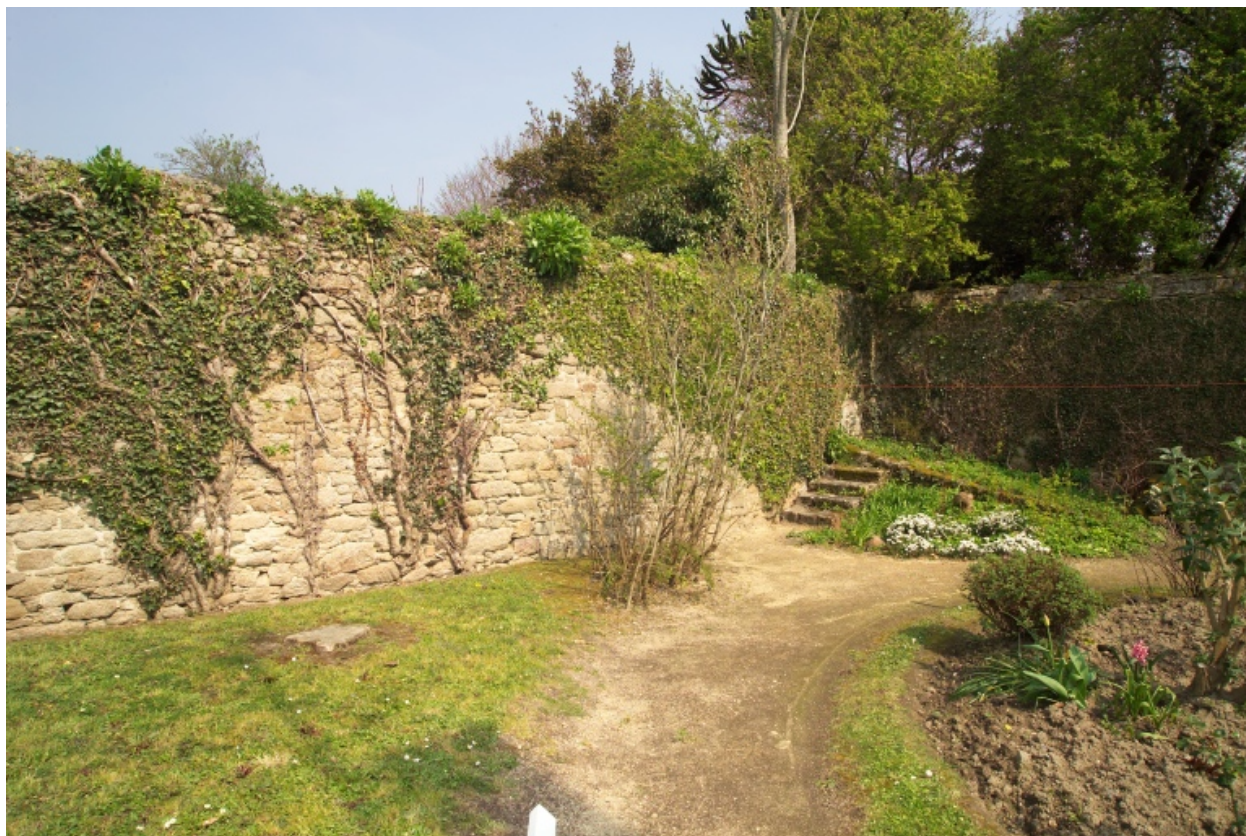
Mur nord de la parcelle AK 5.
