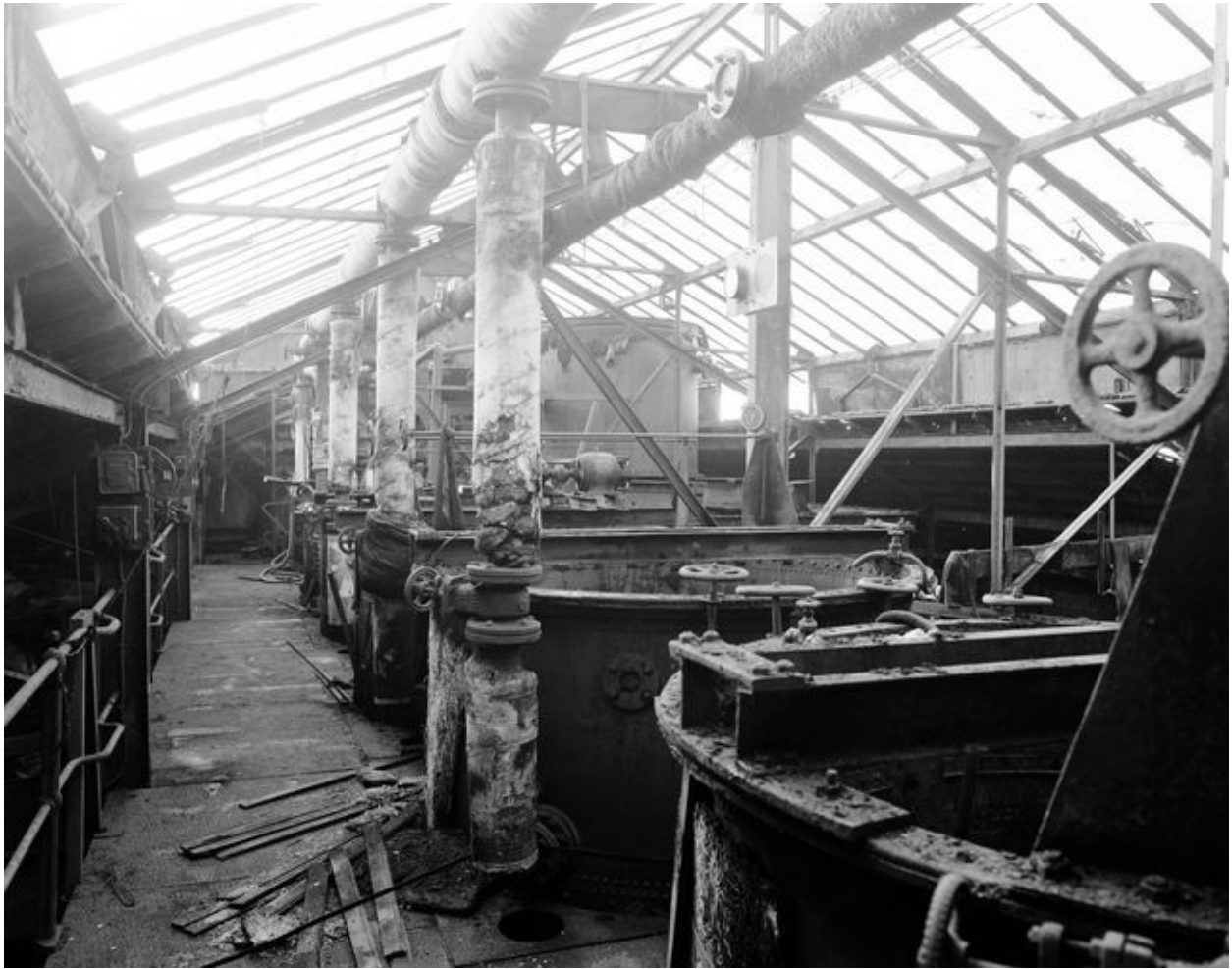
Nouvelle usine. Bâtiment central, 6e étage. Chaudières à clarifier.
