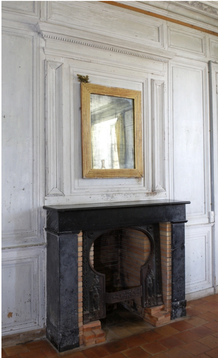
Logis. Cheminée de salle.
