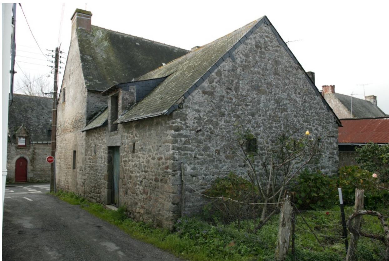
Vue générale vers le Sud.
