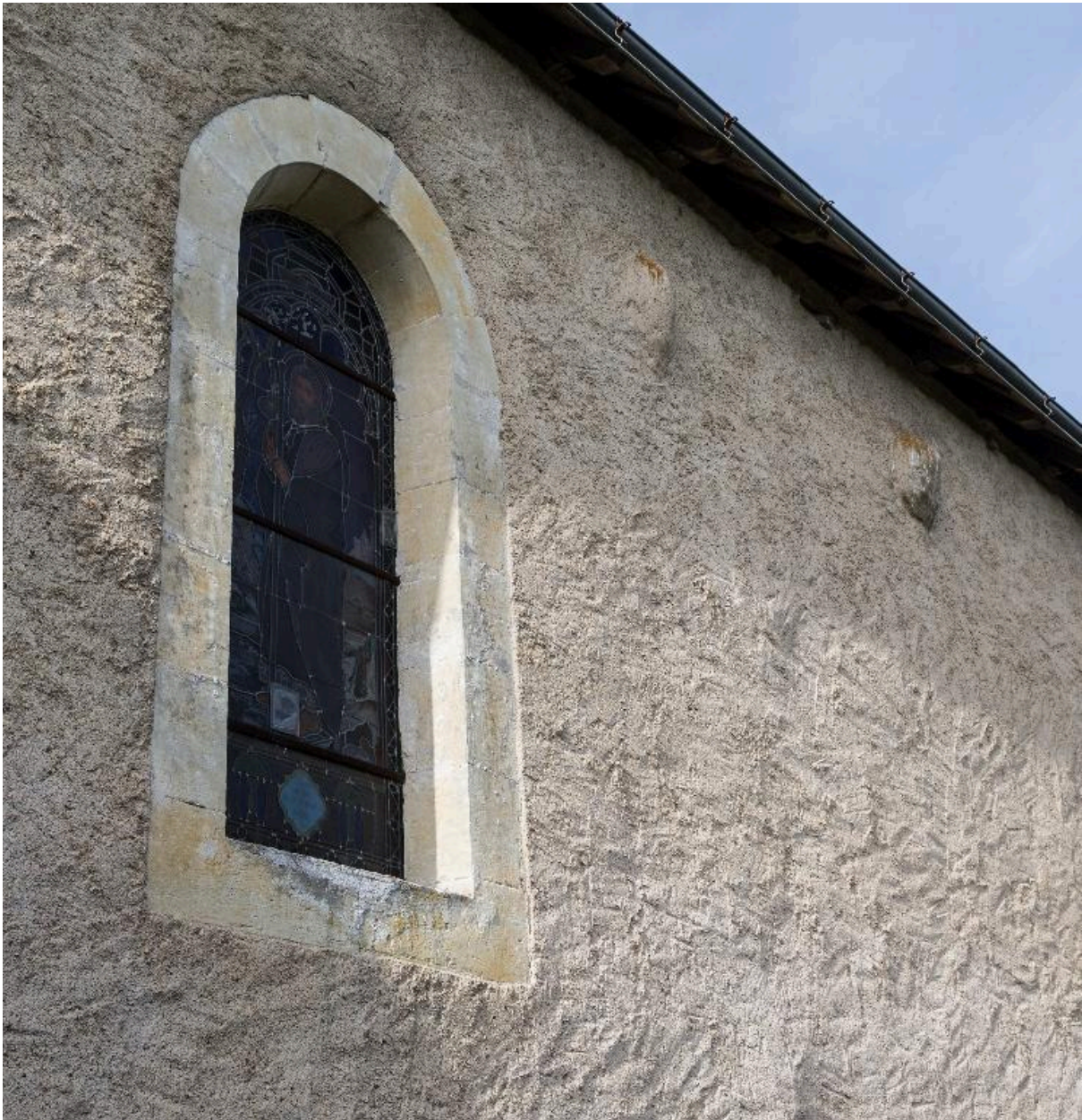
Nef, mur nord : baie (3).
