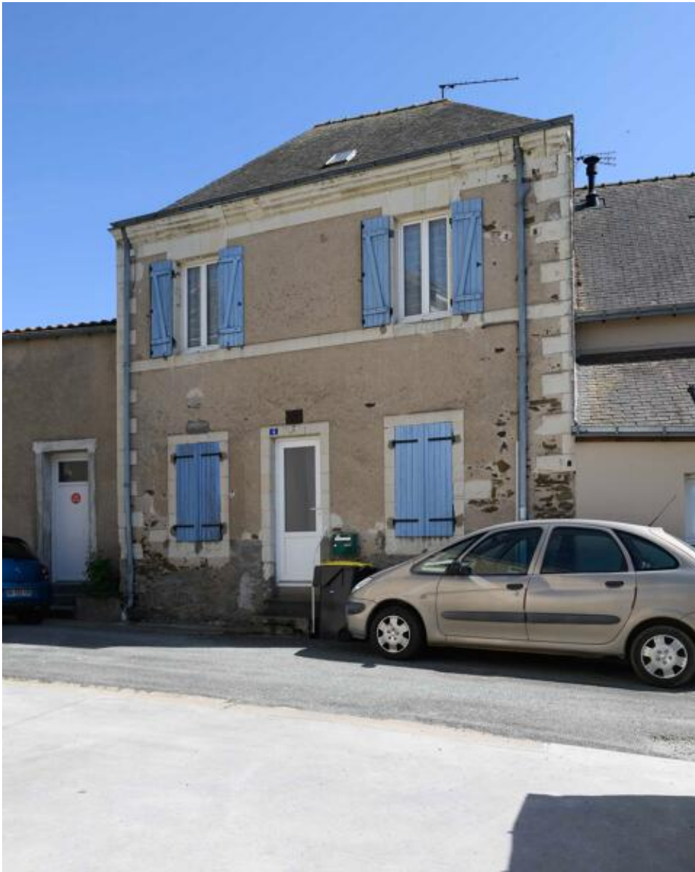
Maison. 4 rue de l'Ecole.
