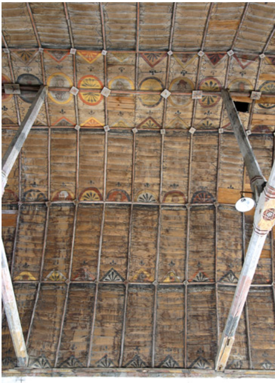
Nef, voûte, côté sud : vue d'ensemble de la troisième travée.
