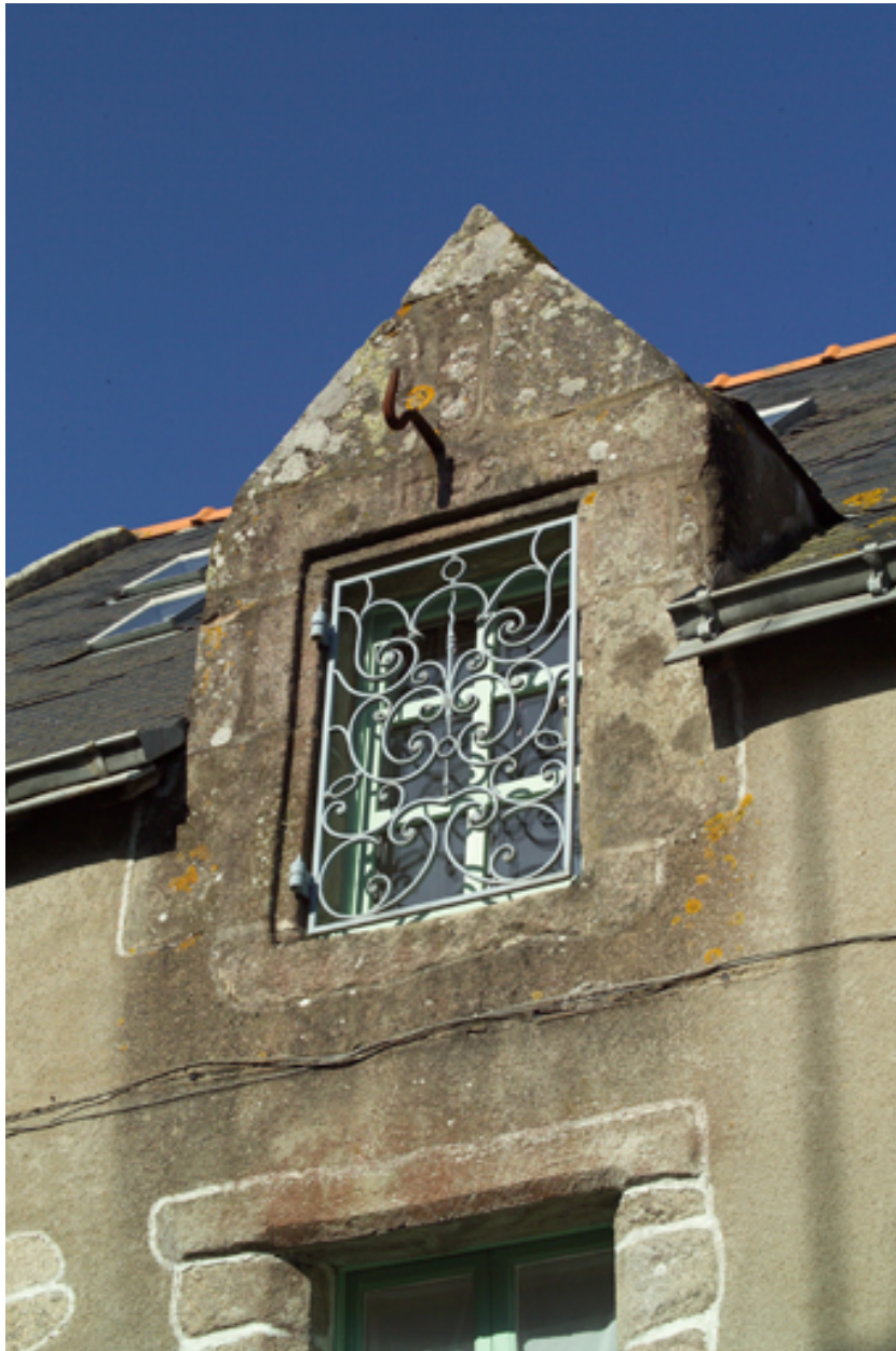
Façade sur rue, détail de la lucarne.
