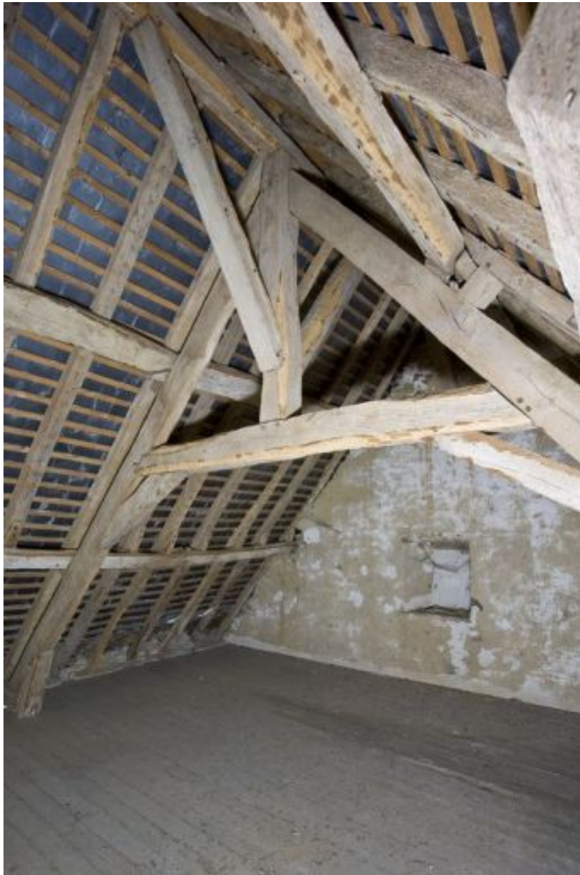
Charpente de la partie est du logis.
