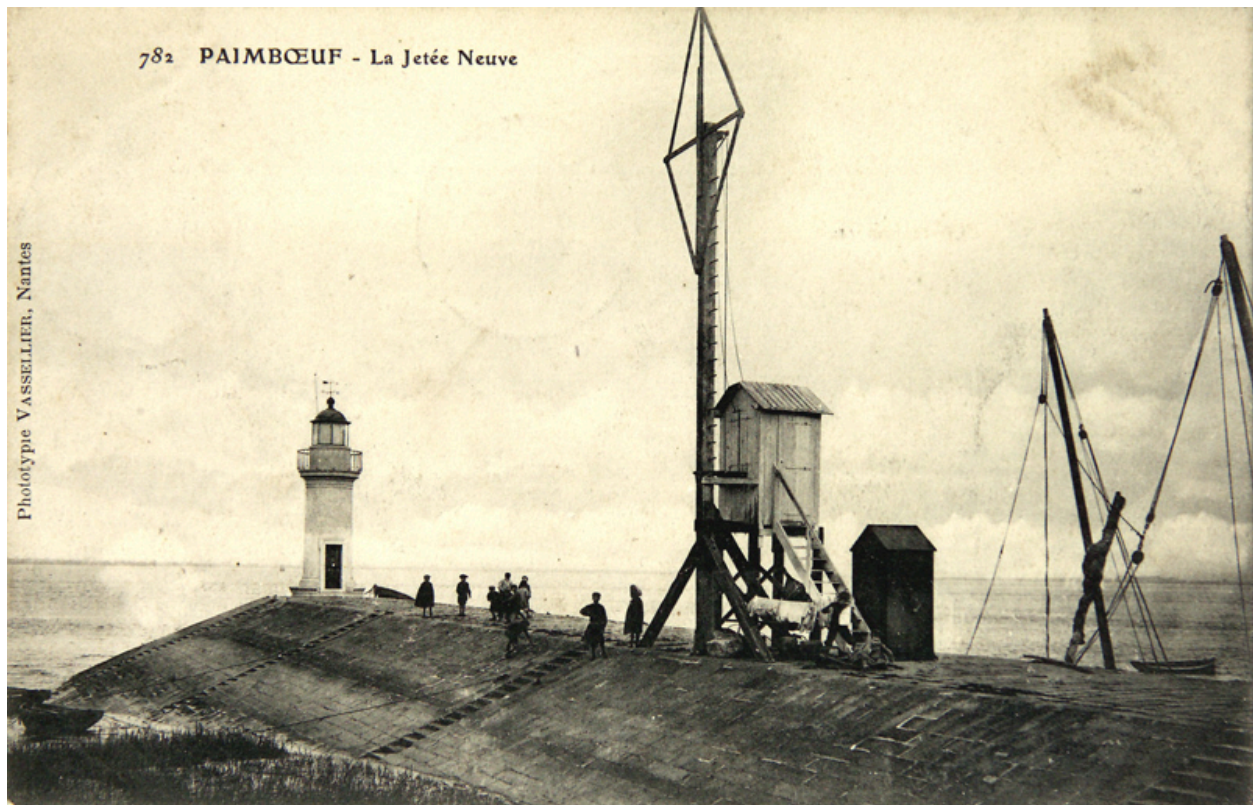
La jetée vue depuis le quai vers la Loire (1er quart XXe siècle).
