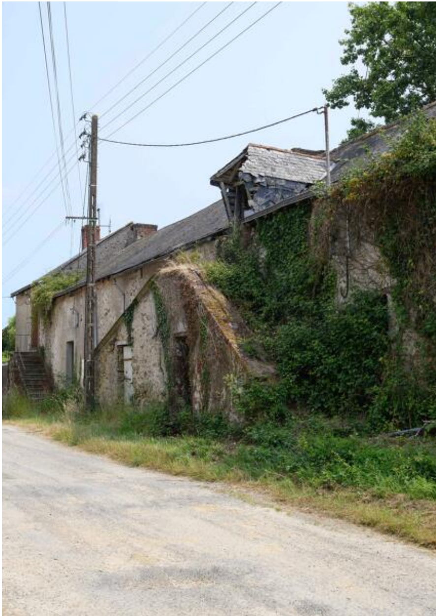
Façade nord des logis de la ferme du Theil.
