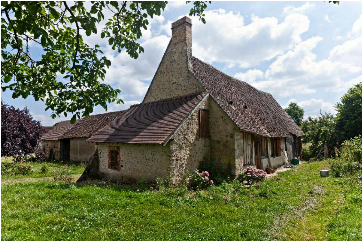
Logis de la ferme 1, vu depuis le sud-ouest.
