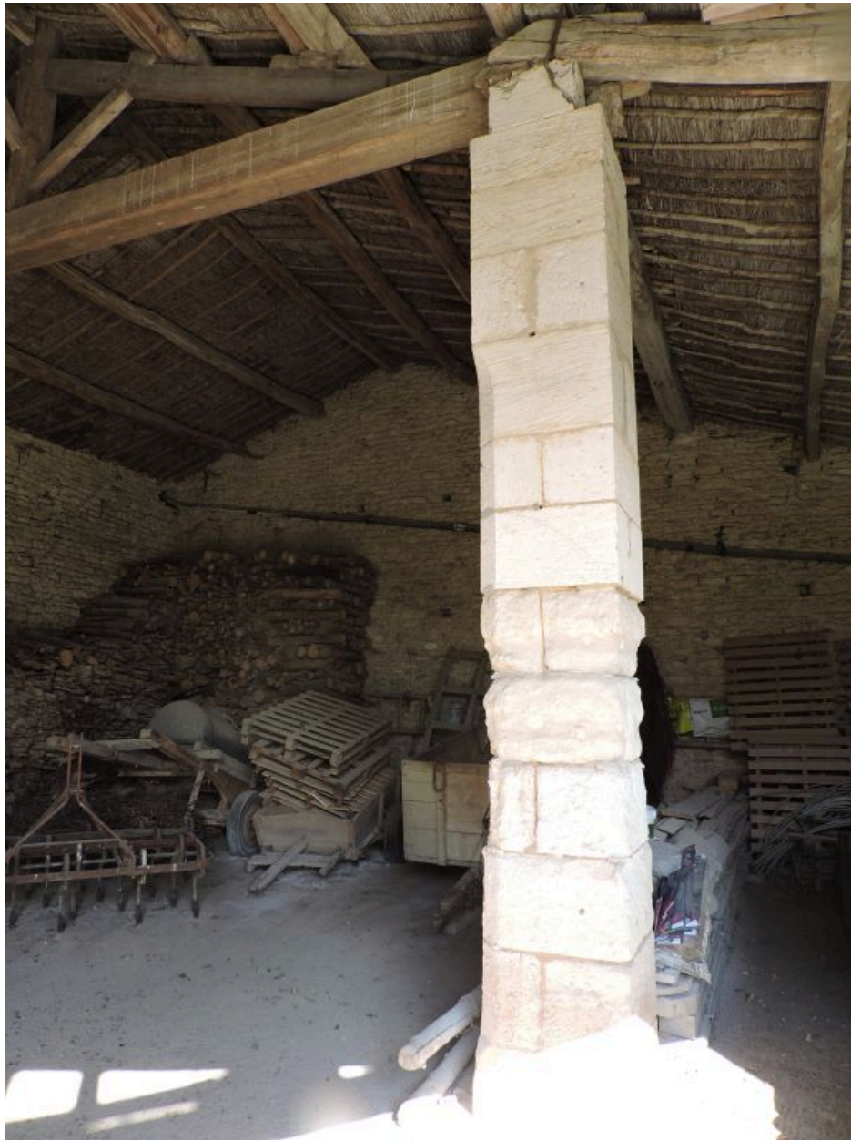
Le hangar, soutenu par un pilier en pierre de taille.
