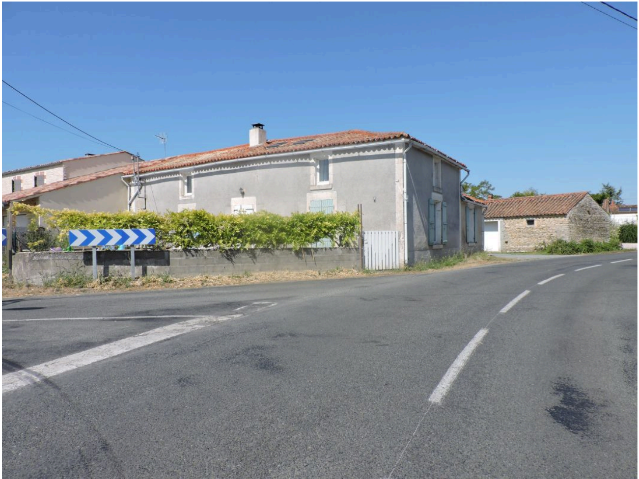
Le logis vu depuis l'est.
