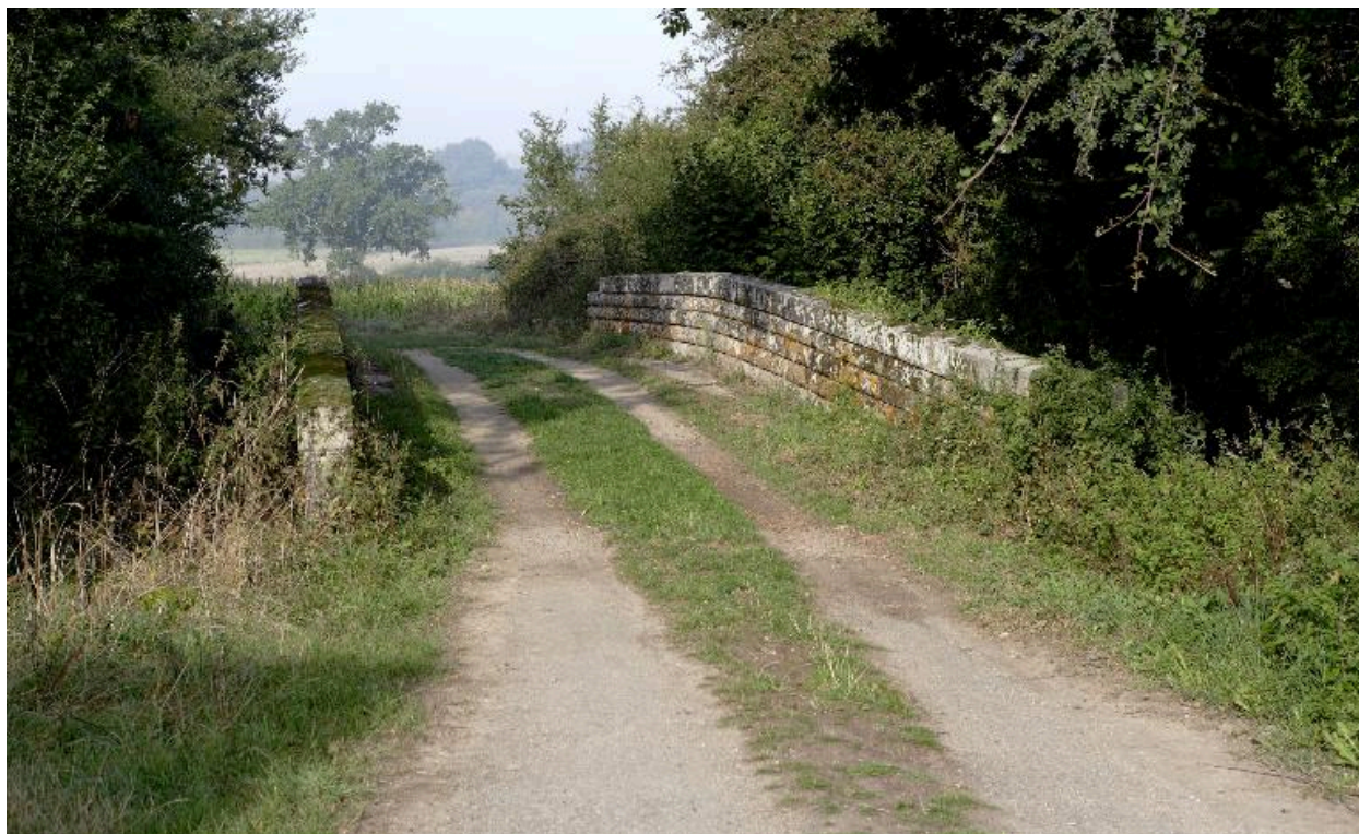
Vue du dessus d'un pont-route.
