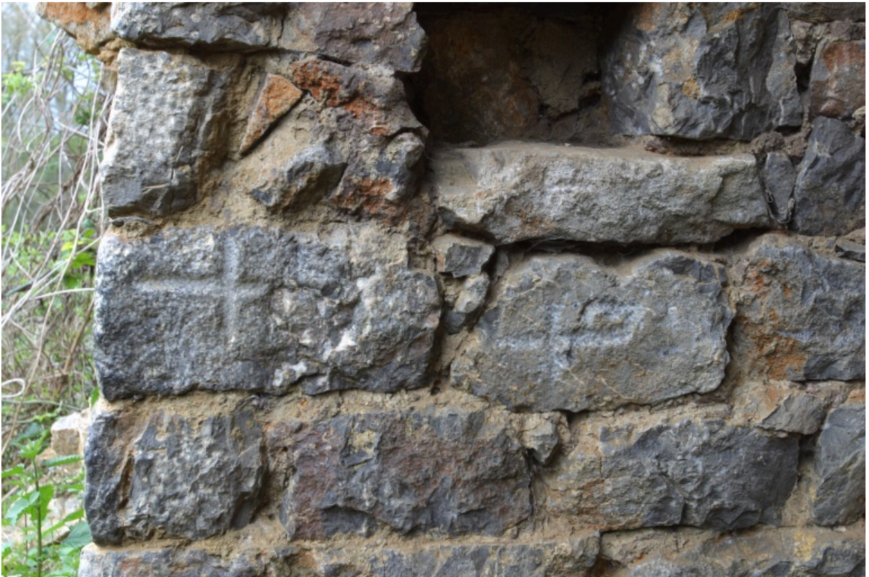
Détail de la maçonnerie du hangar.
