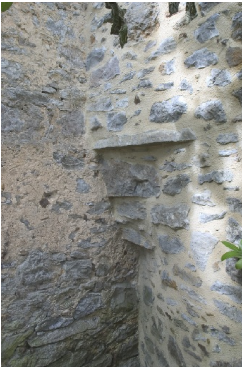
Détail de la façade postérieure de la partie est du bâtiment principal : jonction gauche entre le mur et la tour.
