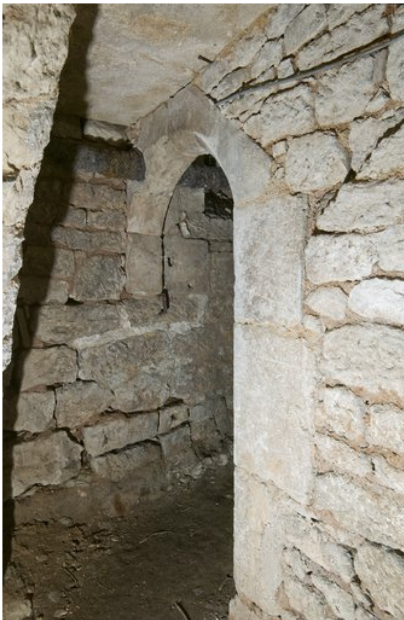
Porte conduisant de la première salle du sous-sol à un caveau et à l'escalier.
