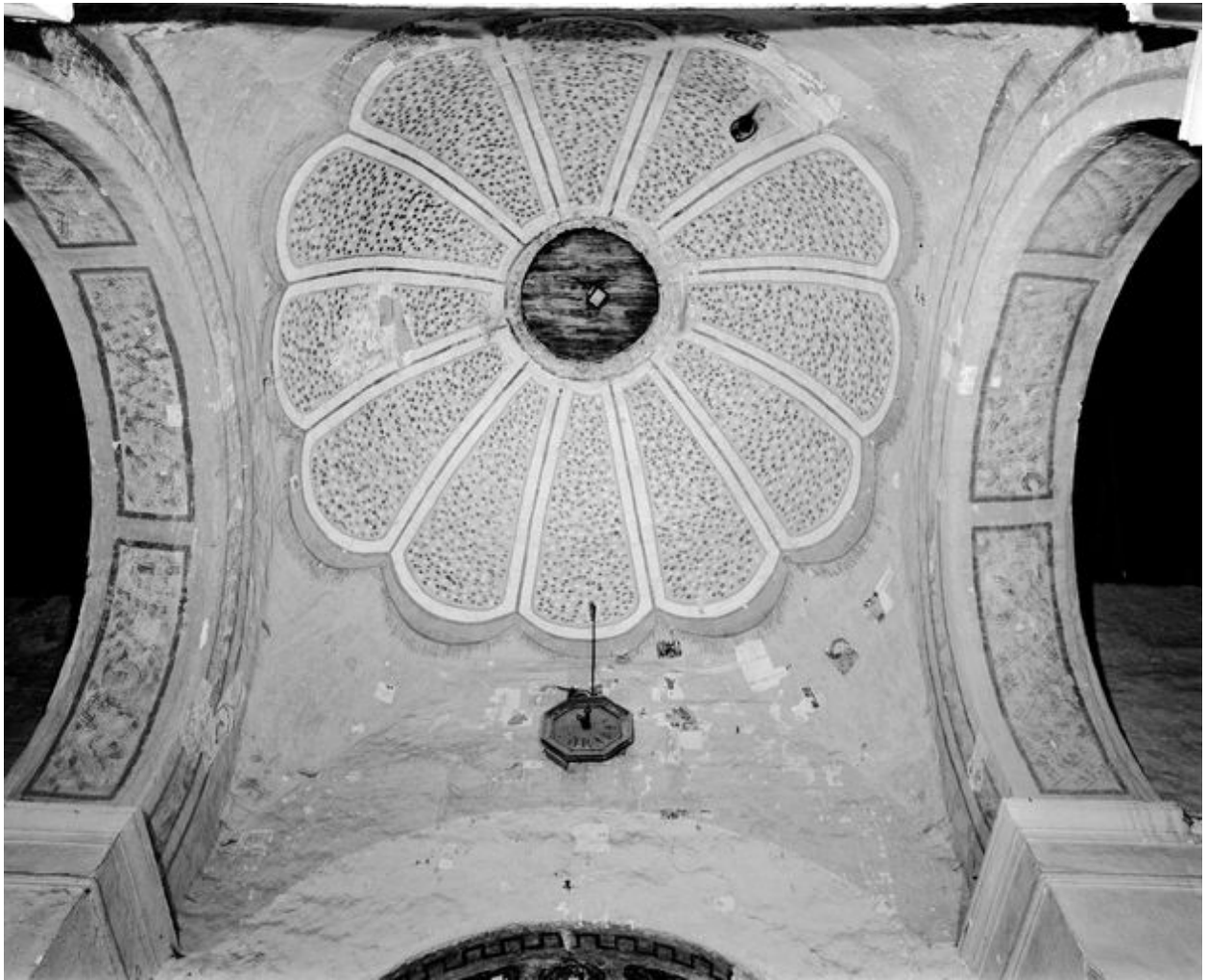
Croisée du transept, coupole : vue d'ensemble des sondages effectués à travers les peintures du XIIIe et du XIXe siècle.
