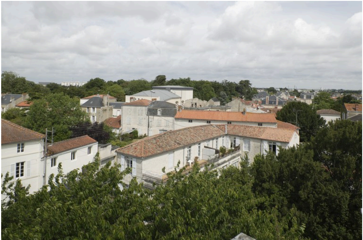
Vue des façades sur cour prises du sud, des toits d'une maison voisine.
