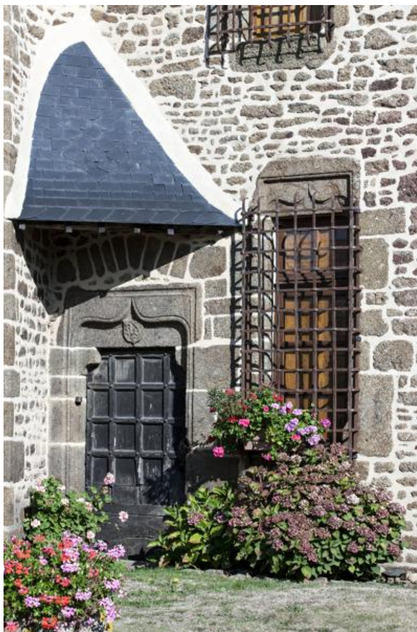
Porte et fenêtre à accolade, façade sud.
