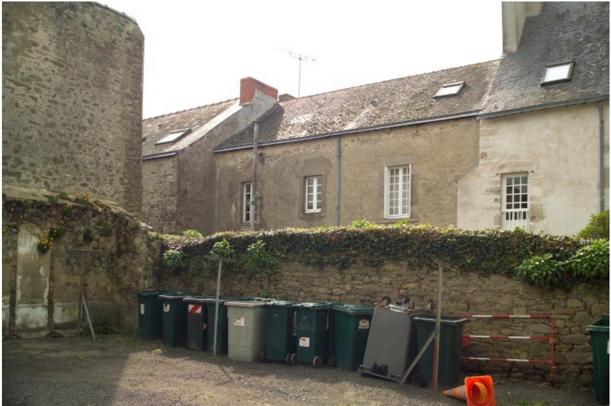
Vue de la façade arrière.
