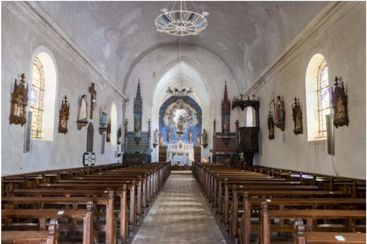
Vue intérieure de l'église et de sa nef depuis l'ouest.
