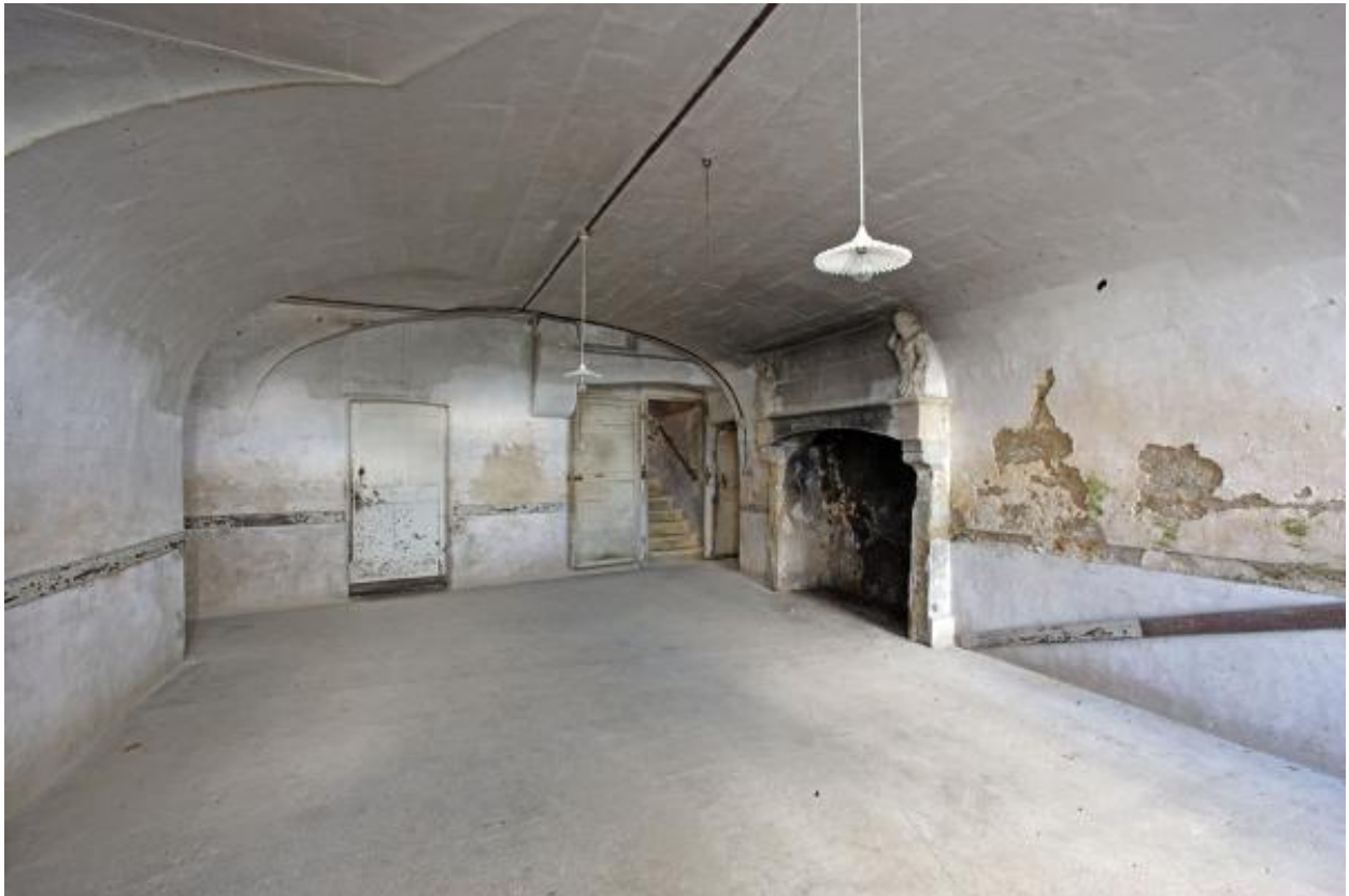
Le sous-sol du pavillon sud.
