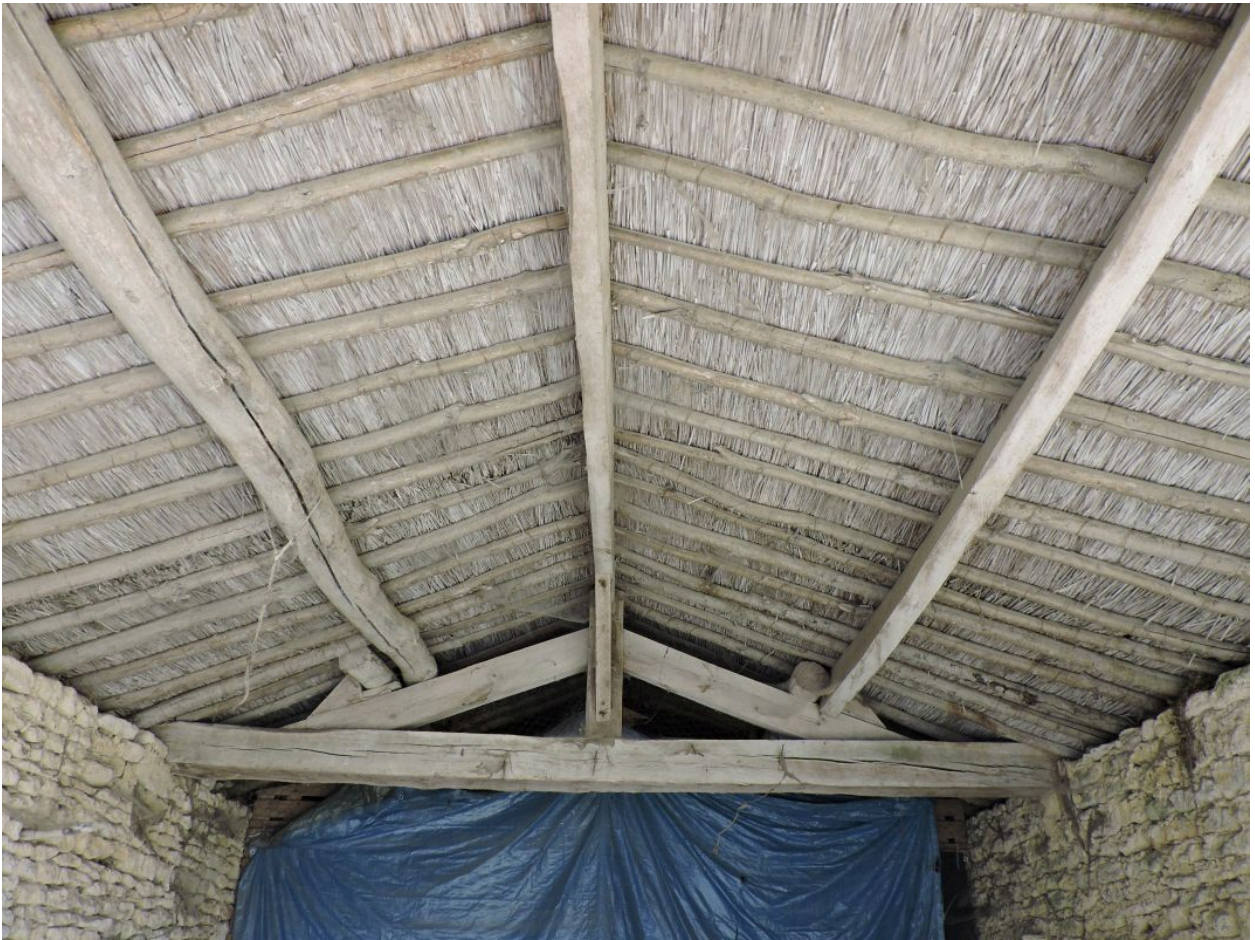
Le toit du petit hangar, en roseau.
