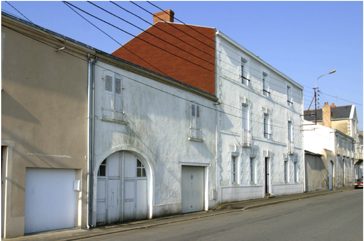
Vue d'ensemble depuis le quai vers l'aval.
