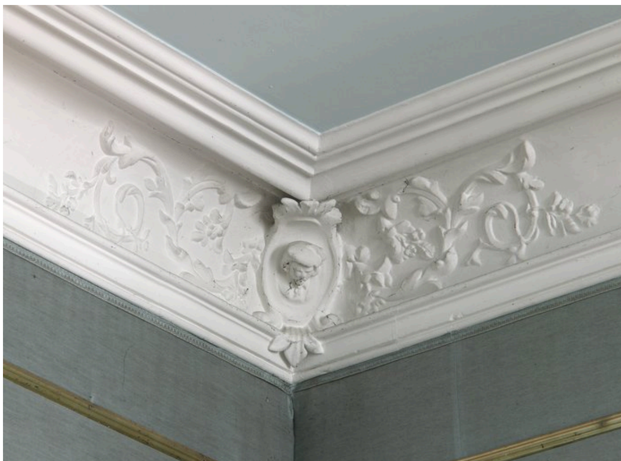
Salon à l'étage : détail de la corniche en stuc.
