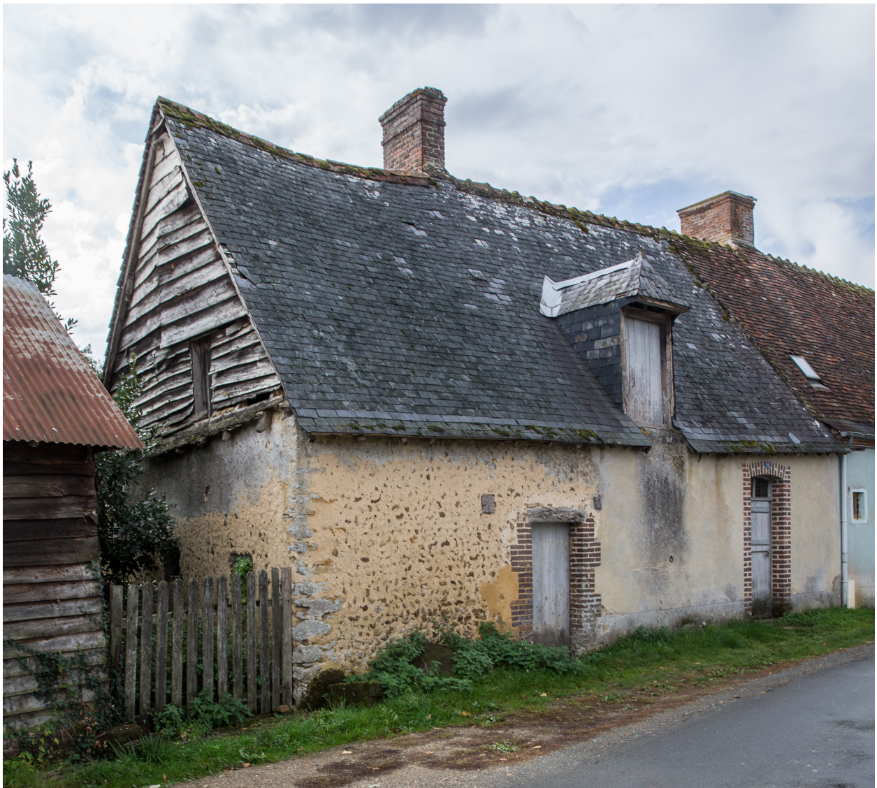
Les bâtiments côté rue.
