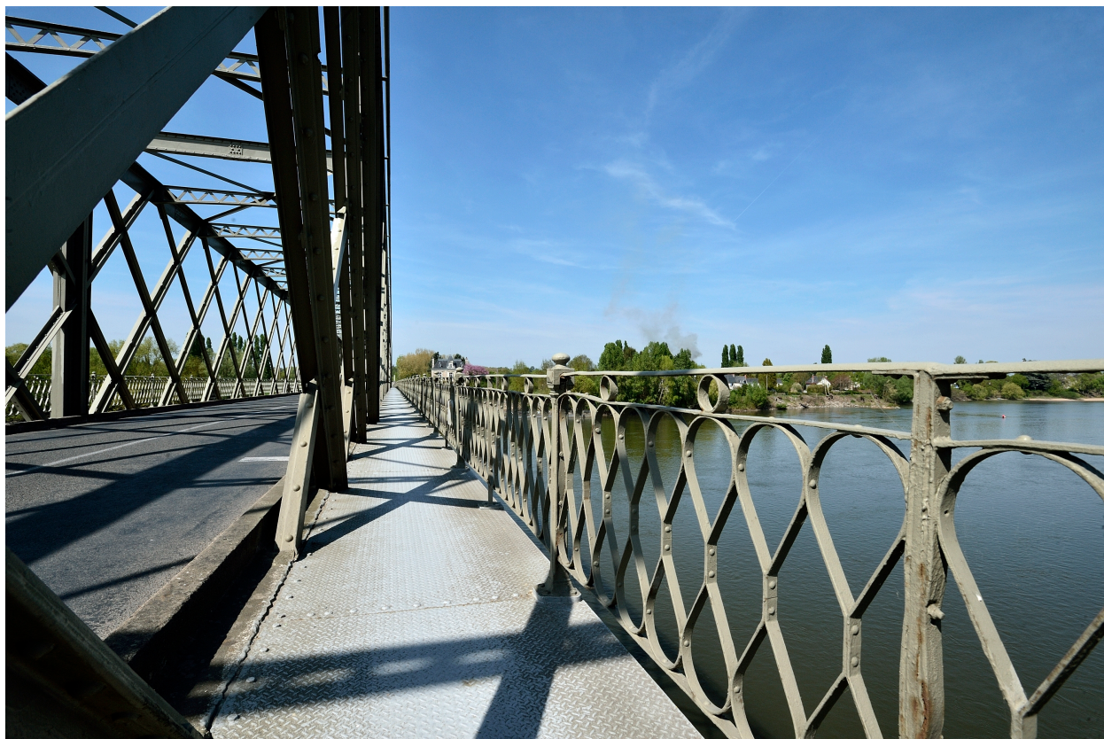
Vue de la passerelle pour les piétons à l'extrémité du pont.
