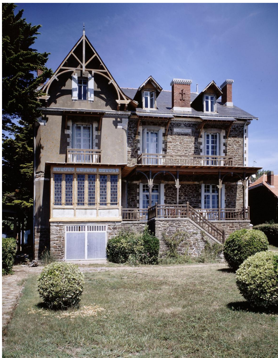
Elévation ouest de la villa La Tempête.
